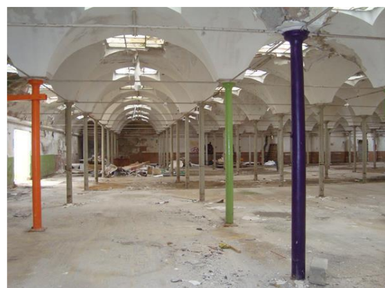
Figure 3 : Salle des colonnes (4 230 m 2 )
